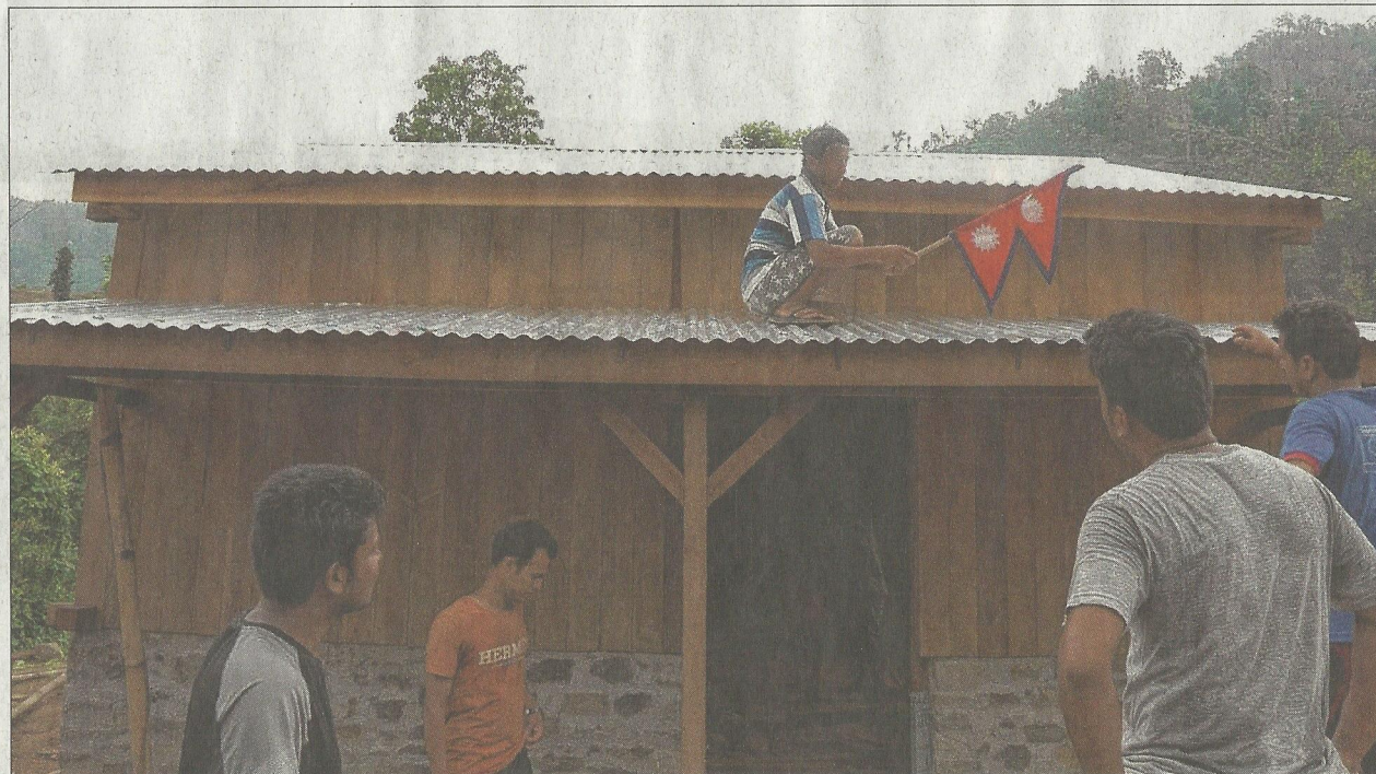
Eines der neuen, erdbebensicheren Häuser, das die durchs Erdbeben obdachlosen Nepalesen mit kräftiger Unterstützung von Govinda bauen. (Foto: privat)
