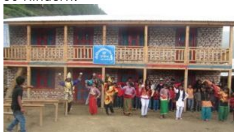
Das neue Schulgebäude in Puru
