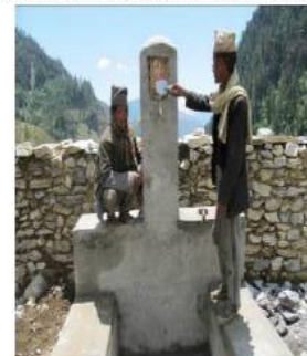
Fertig gebaute Trinkwasserstelle
