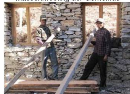
Installation der Fenster in der Schule
