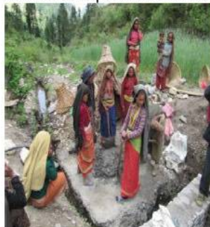
Bau der Trinkwasseranlage Patmara
