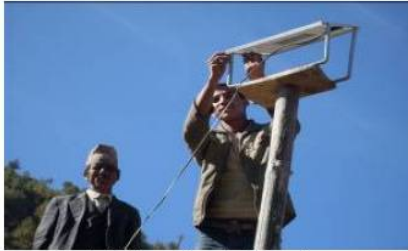
Installation der Solaranlagen
