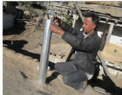
Installation des Rauchabzugs
