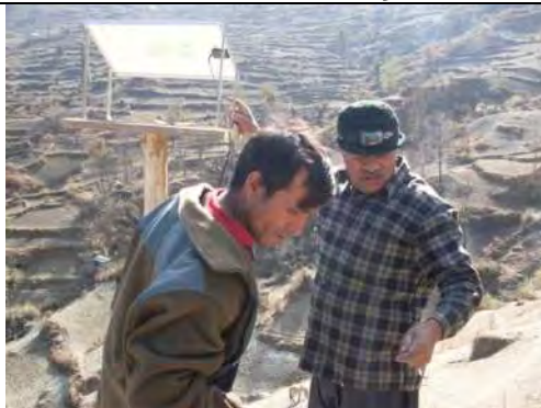
Installation der Solaranlagen
