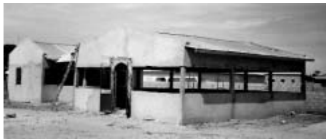
Die Speisehalle und Küche des Dindingo-Kindergartens in Gambia, der mit Unterstützung von Govinda gebaut werden konnte.
